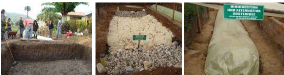
Foto No 4 Construcción de biodigestores en las unidades productivas
