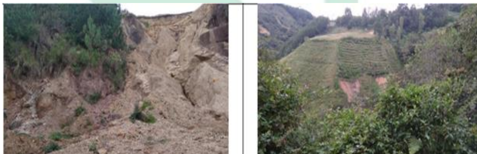
Foto No.23. Deslizamientos en vías y laderas en la vereda Chimayoy Alto – municipio San Pedro de Cartago.
