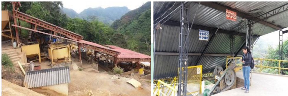
Foto No.75 visita de seguimiento y control ambiental a plantas de tratamiento.
