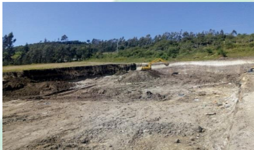
Foto No. 62. Celda de contingencia relleno sanitario ISERVI-Ipiales
