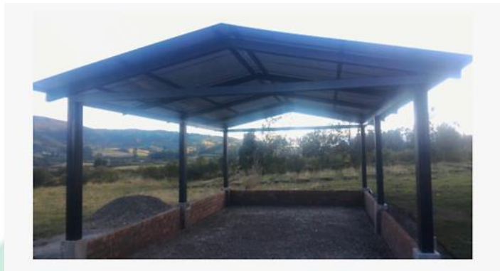
Foto No. 67. Construcción de cubierta en estructura metálica para el CAV en la sede de CORPONARIÑO, en el municipio de Túquerres
