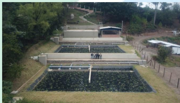
Foto No.45. Planta de tratamiento de aguas residuales en San Pedro de Cartago
