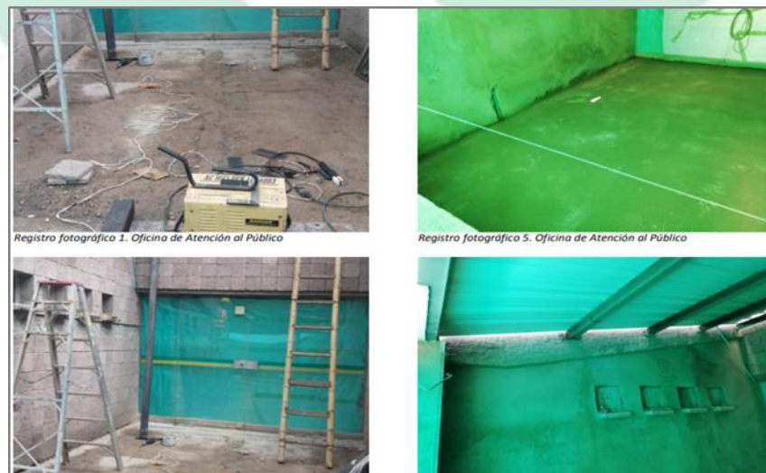
Foto No. 69. Adecuación y construcción de la oficina para atención al usuario en la sede central de CORPONARIÑO - Pasto
