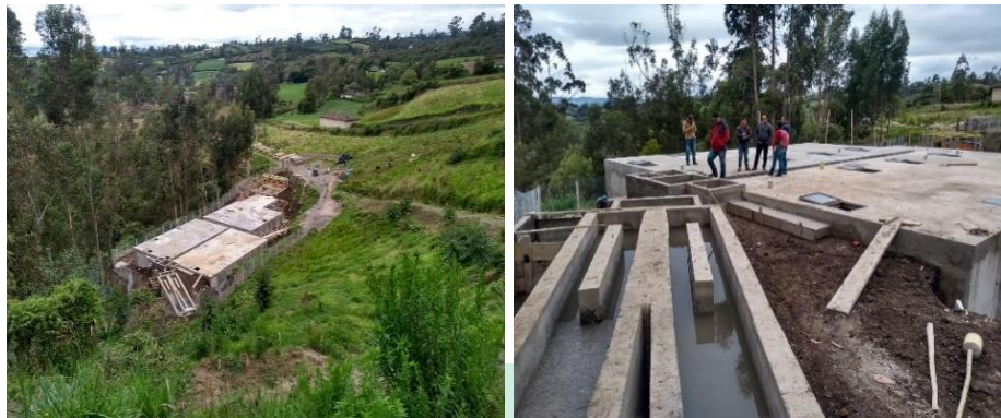
Foto No. 44. Construcción de PTAR en el municipio de Gualmatán.
