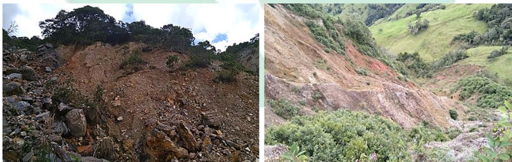
Foto No. 24. Deslizamientos parte alta quebrada El Rollo
