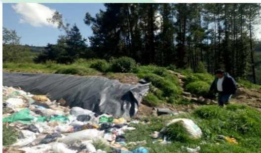
Foto No. 63. Celda 3 relleno sanitario ISERVI-Ipiales
