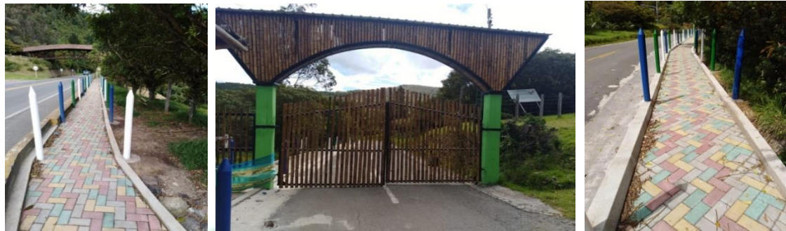
Foto No.68.. Obras adelantadas en el Centro Ambiental Chimayoy
