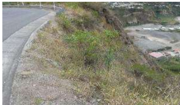
Foto 5. Estado inicial del sitio de obra, vía Pilcuán – Funes
