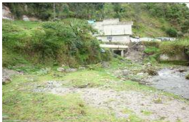
Foto 3. Estado inicial del sitio de obra, sector Fenelon Ordoñez antigua vía la Cruz-San Pablo.
