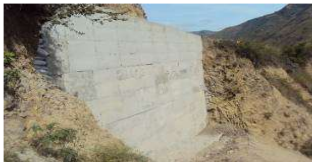
Foto 6. Muro de contención en concreto reforzado, vía Pilcuán – Funes
