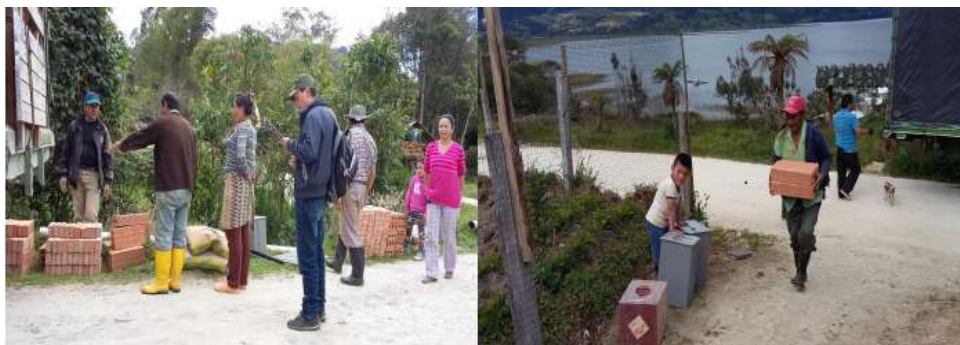
Foto 20. Entrega de insumos para la construcción de estufas ecoeficientes en la vereda Casapamba Corregimiento de El Encano
