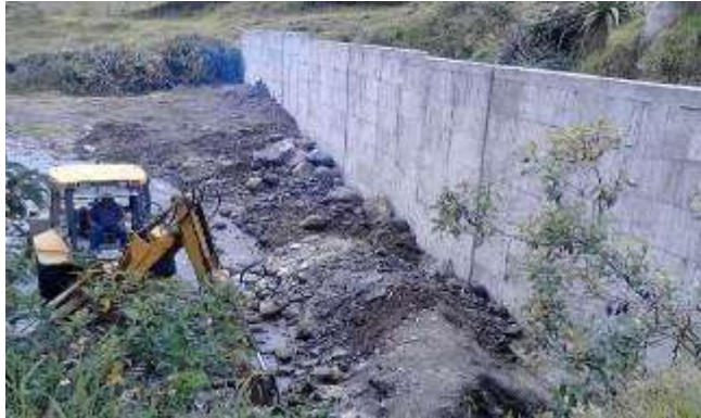
Foto 4. Muro de contención en concreto reforzado, sector Fenelon Ordoñez antigua vía la Cruz - San Pablo.
