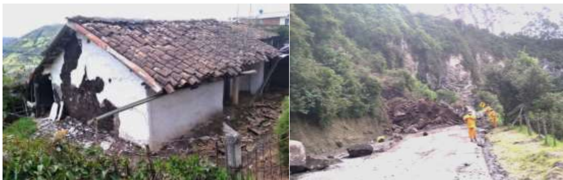
Foto 4. Daños estructurales en las viviendas y la vía de las poblaciones de Mapachico y Genoy, afectadas por el sismo del 12 de junio de 2018
