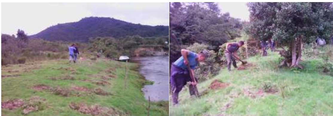
Foto 35. Área en proceso de restauración
