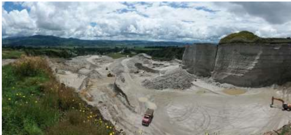
Foto 45. Seguimiento, control y monitoreo de extracción de materiales de construcción.
