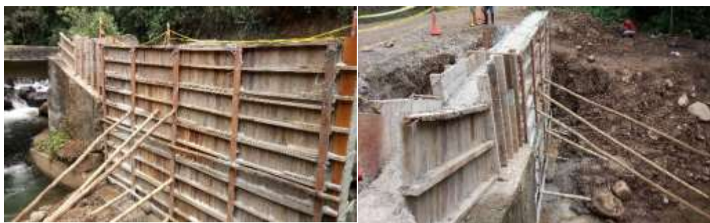
Foto 6. Obras de mitigación municipio de Chachagüí
