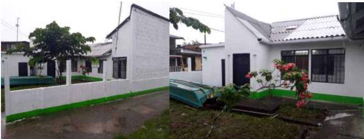
Foto 55. Mejora de sede el Charco, después de las adecuaciones
