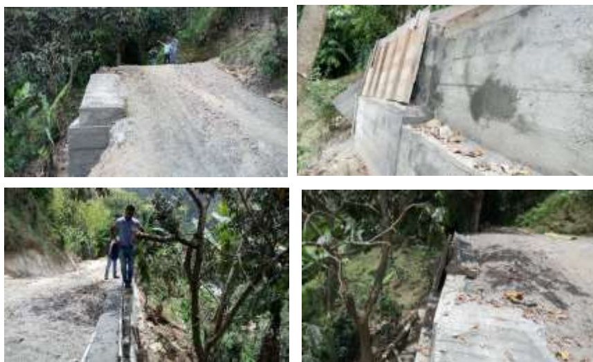
Foto 7. Obras de mitigación municipio de Colón Génova
