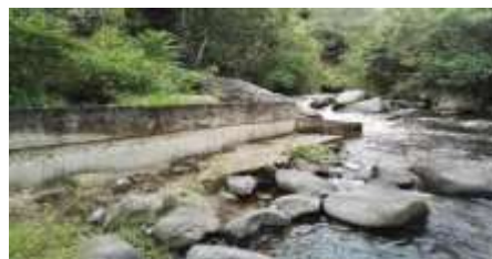
Foto No. 6. Captación distrito de riego
