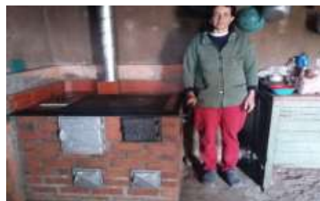
Foto No. 23. Estufa eficiente construida, en la vereda San Francisco, municipio de El Contadero
