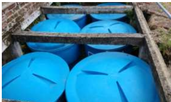
Foto No. 66. Sistema de recolección de aguas lluvias.
