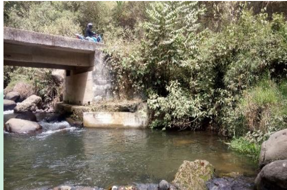
Foto No 11. Visita técnica para construcción de muro de contención, sector la Victoria, municipio de Chachagüí.
