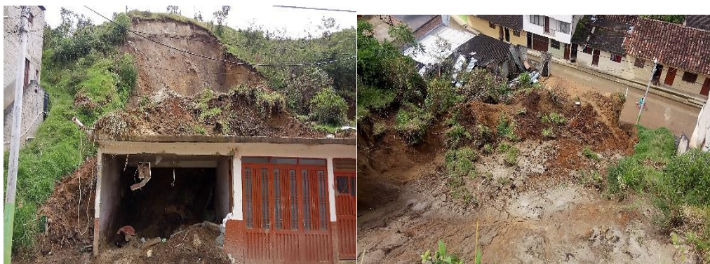
Foto No 8. Proceso de remoción en masa en perímetro urbano, barrio 20 de Julio, municipio de Belén.
