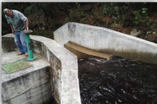
Foto No. 6. Captación Acuabuesaco
