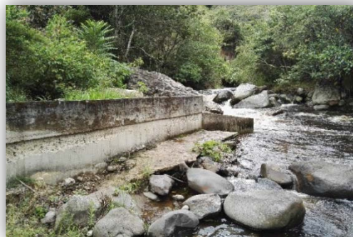
Foto No.7. Captación distrito de riego
