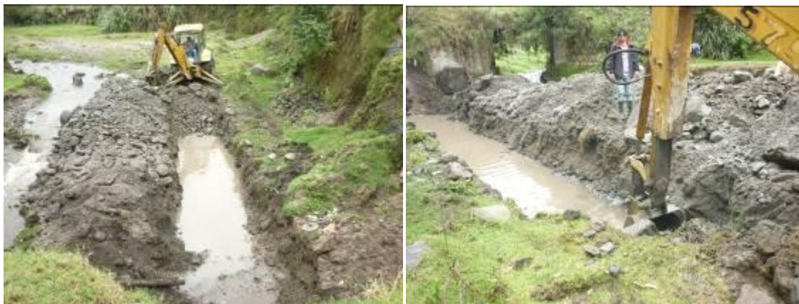
Foto No. 3. Excavaciones mecánicas bajo agua para la zarpa del muro de Contención sector Fenelón Ordoñez antigua vía La Cruz-San Pablo. Municipio de La Cruz
