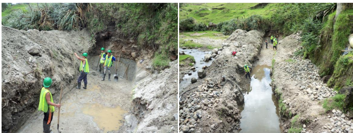
Foto No. 2. Excavaciones manuales bajo agua, para la nivelación del piso de la zarpa del muro de contención, a una altura de 1.40 m y 2.60 m de ancho - sector Fenelón Ordoñez antigua vía La Cruz- San Pablo. Municipio de La Cruz.
