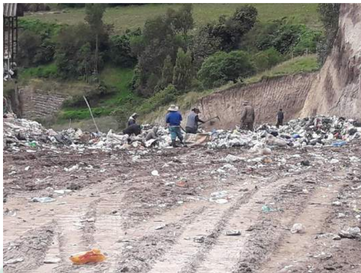
Foto No. 35 Compactación manual de residuos – Relleno La Victoria Ipiales
