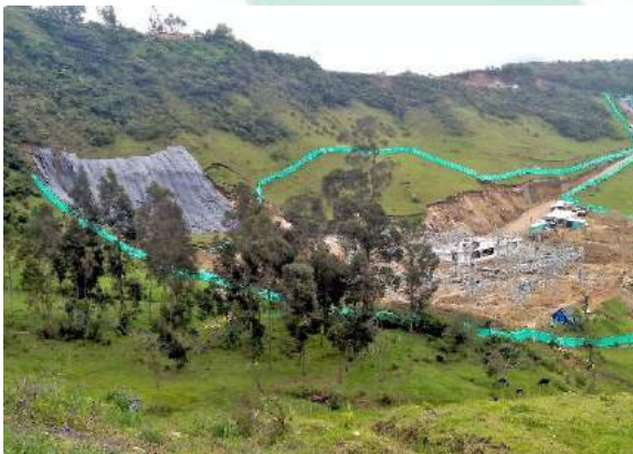
Foto No. 15 Seguimiento realizado al municipio de San Pedro de Cartago - Subestación Eléctrica e intervención ambiental - paisajística
