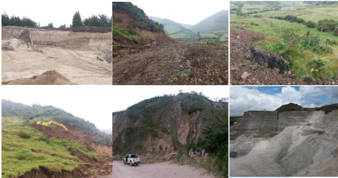
Foto No. 38 Control, monitoreo y seguimiento extracción de materiales de construcción
