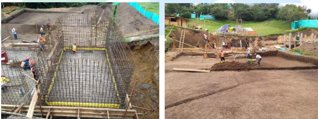
Foto No. 22 Construcción PTAR – Pupiales y Santacruz de Guachaves
