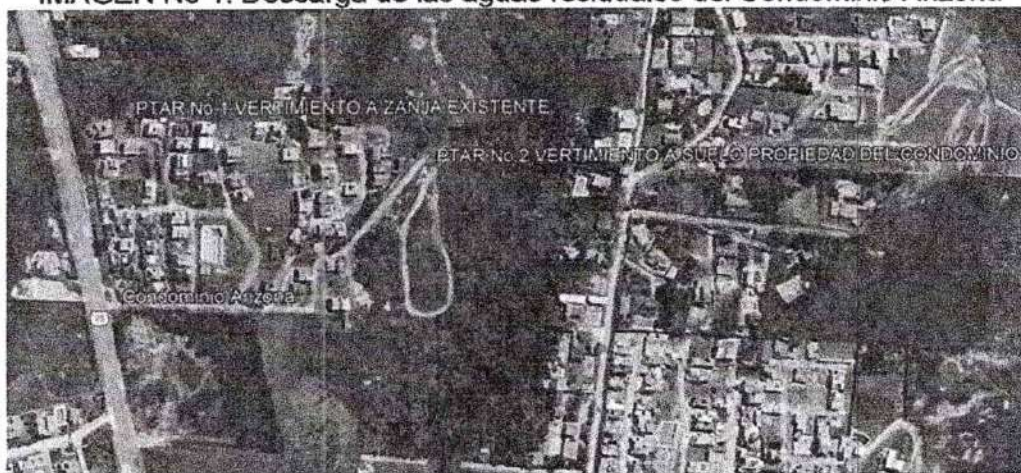
IMAGEN No 1. Descarga de las aguas residuales del Condominio Arizona
