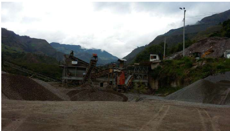
Figura N° 9. Vista general de la zona de la Planta de Producción de Triturados Fuente: Este proyecto, Enero de 2018. Panavías S.A. – Mina El Capulí – Municipio de Iles.
