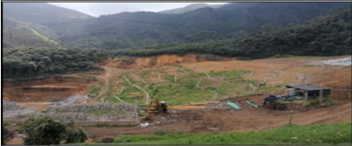
Adecuaciones técnicas, operativas y ambientales Relleno Sanitario Antanas
