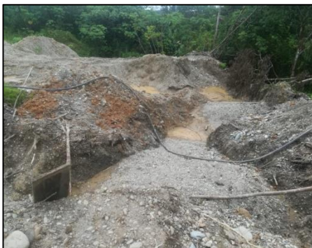
Afectaciones generadas por la extracción de
