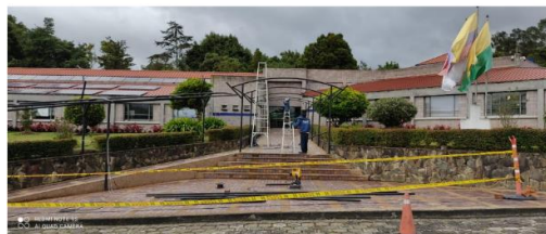
Foto. Adecuación y mejoramiento de las instalaciones de la sede central de CORPONARIÑO en la ciudad de Pasto, Nariño.
