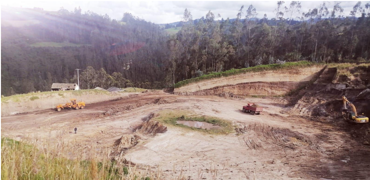
Adecuaciones Técnicas, operativas y ambientales, Celda No 5. Relleno Sanitario la Victoria
