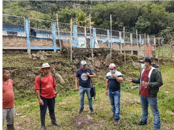
Obra mitigación municipio de Colón
