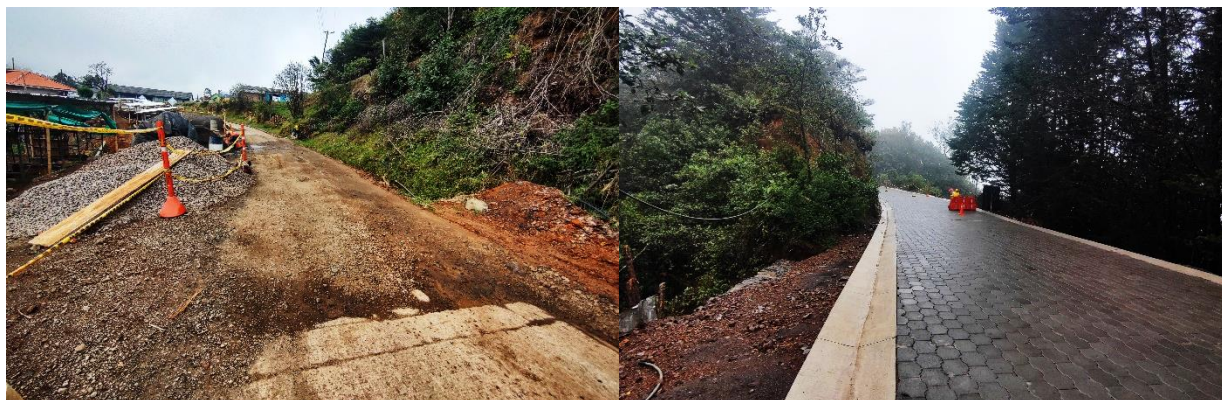
Figura 15 Obras de mitigación en la vía como muros en gaviones y adoquín.
