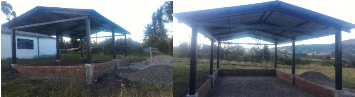
Foto No.50.. Construcción de la cubierta en estructura metálica para el CAV del Municipio de Tuquerres.
