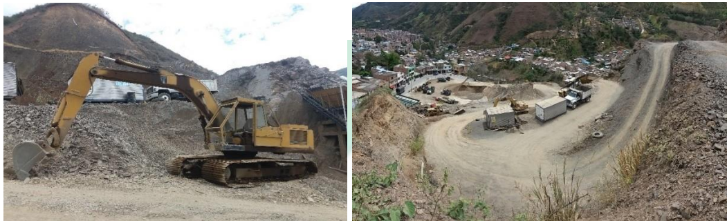
Fotos No..48. Seguimientos a minas de extracción de materiales de construcción
