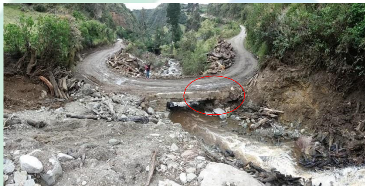
Foto No.13 Sector identificado en el municipio de la Cruz para adelantar la obra de mitigación
