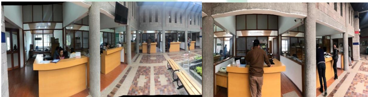
Foto No. 57 Adecuación del bloque central de la sede de CORPONARIÑO en Pasto
