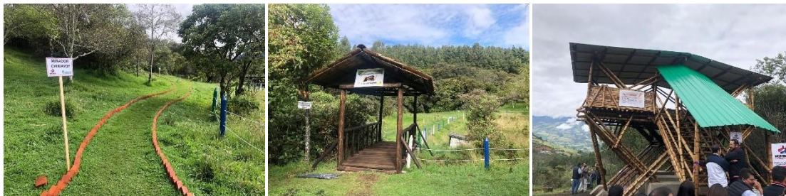
Foto No 58 Adecuaciones en el Centro Ambiental Chimayoy
