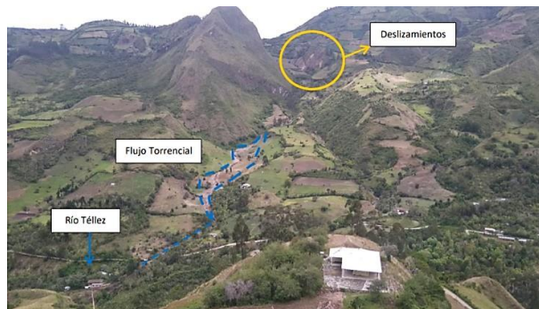
Foto No 08. Avenida torrencial Vereda La Vega – sector El Cajón
