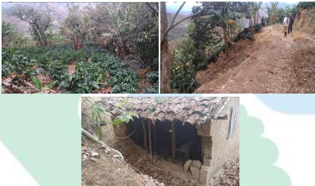
Foto No 09. Áreas con inestabilidad de terreno en el municipio de Arboleda – vereda San Pedro Bajo
